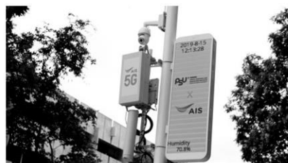
Smart Pole ที่ติดตั้งสถานีฐานกระจายสัญญาณ 5G ของเอไอเอส
