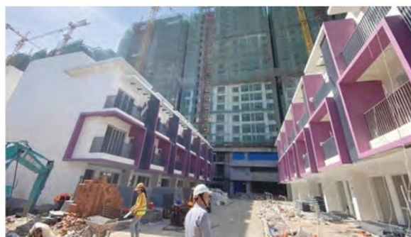
สภาพที่พนักงานก็ฟ้าที่ยังสร้างไม่เสร็จ
