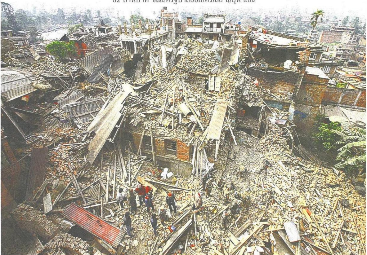
▲ เหลือแต่ซาก เจ้าหน้าที่กู้ภัยเร่งเข้าชุดค้นหาผู้รอดชีวิตได้ซากปรักหักพังของอาคารบ้านเรือนในกรุงกาฐมาณฑุ เมืองหลวงของเนปาล ที่ถล่มราบหลังเกิดเหตุแผ่นดินไหวรุนแรงขนาด 7.8 แมกนิจูด ทำให้มีผู้เสียชีวิตกว่า 2 พันคน บาดเจ็บกว่าครึ่งหมื่น และระบบสาธารณสุขโลกของเมืองพังพินาศ.
