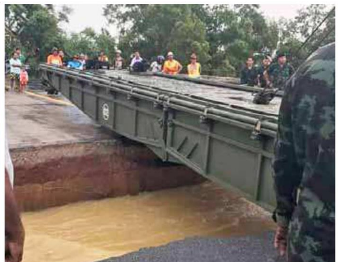
ทหารช่าง เข้าติดตั้งสะพานแบริ่ง บริเวณถนนสายบ้านตุล - ชะอวด เพื่อเข้าช่วยเหลือประชาชนหลังสะพานถูกน้ำซัดขาด
