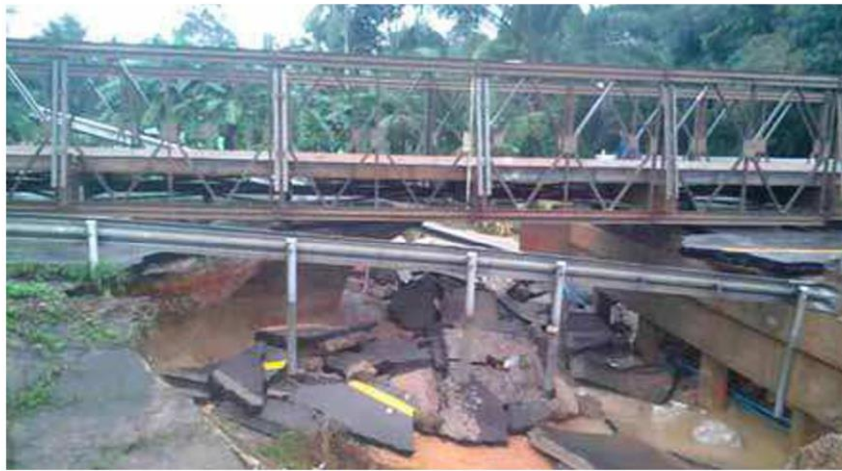
แขวงทางหลวง จ.สุราษฎร์ธานี ติดตั้งสะพานเบร้ง บนถนนสายเอเชีย
