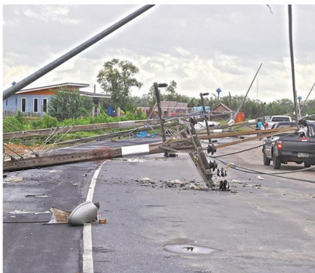
เสาไฟฟ้าล้มระเนระนาด จ.นครศรีธรรมราช
