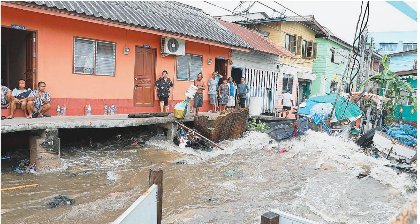
พังทลาย ฤทธิ์พายุ “ปายิก” ที่พัดผ่าน จ.ระยอง ทำให้เกิดคลื่นพัดกระหน่ำถล่มชุมชนชายทะเล อ.สัตหีบ บ้านเรือนและสะพานพังเสียหายหลายหลัง ท่ามกลางความตกใจของชาวบ้าน.
