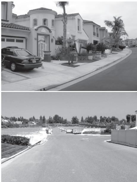
การก่อสร้างถนนและสาธารณูปโภค ในหมู่บ้านจัดสรร
