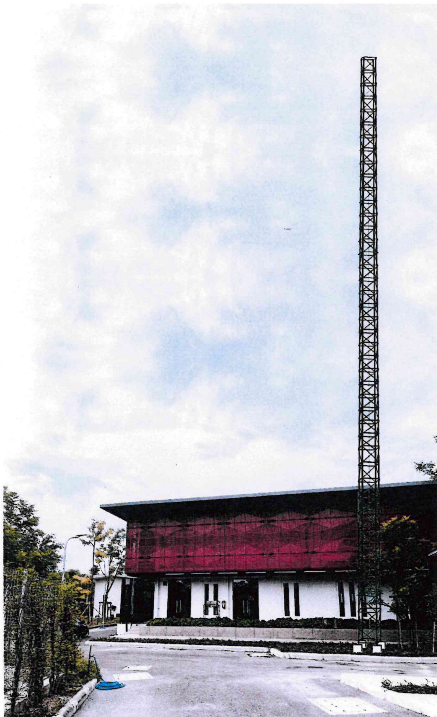
ภาพถ่ายแสดงตำแหน่ง เสาอากาศวิทยุคมนาคมแบบ Self Support Tower
