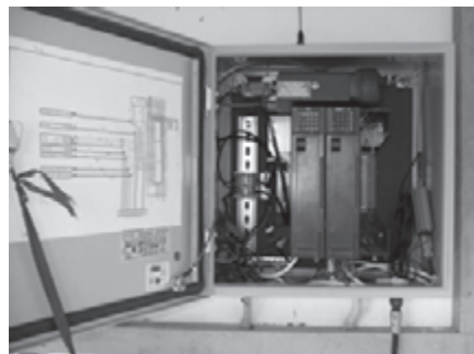
รูปที่ 2.5 remote terminal unit (RTU) และ radio modem
