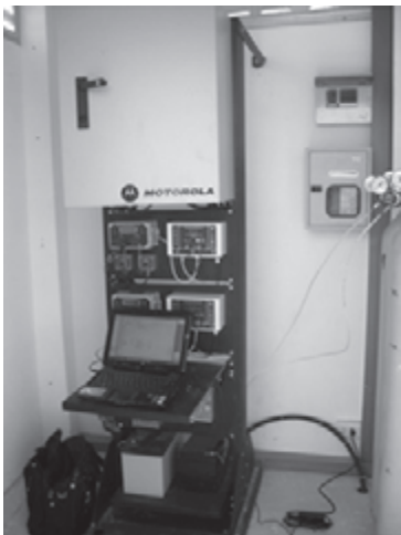
รูปที่ 2.5 remote terminal unit (RTU) และระบบสื่อสารข้อมูลของสถานีโทรมาตรประตูระบายน้ำ
