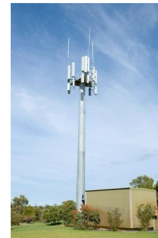
เสาคอนกรีต
