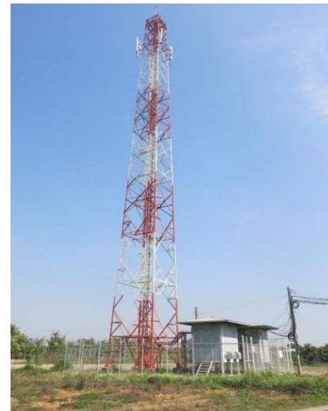
หอคอยโครงสร้างเหล็ก
